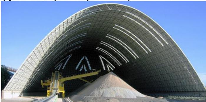
Своды, как правило, усилены ребрами через каждые несколько метров. Некоторые архитектурные своды являются длинными пространственными стержневыми конструкциями, спроектированными в нужной геометрии.
