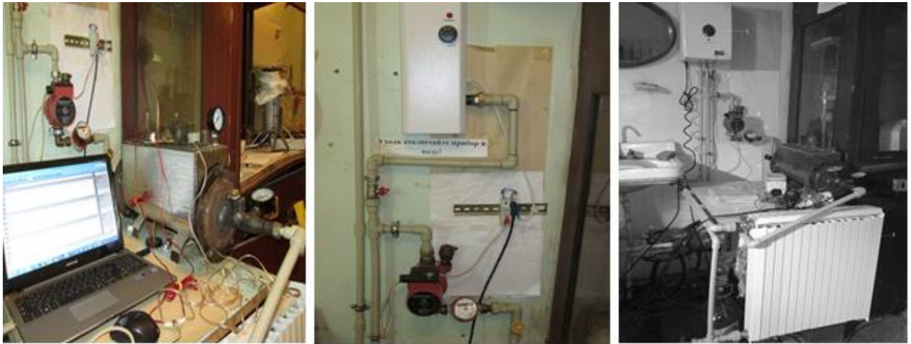
Рисунок 5.1 – Общий вид экспериментальной тепловой установки с ТА, включающий теплоаккумулятор, генератор теплоты, краны, циркуляционный насос, расходомер, панельный радиатор
